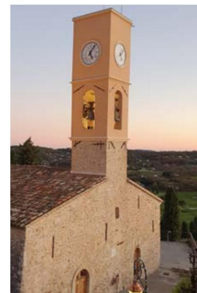
Les interventions d'entreprises spécialisées ont été nécessaires à l'extérieur comme à l'intérieur du bâtiment notamment pour restaurer la structure en béton armé, renforcer la dalle de terrasse et de plancher du clocher, ou encore sécuriser les accès. D'autres prestations se sont ajoutées au projet telles que la révision de l'éclairage, le remplacement du paratonnerre, la sécurisation de l'accès intérieur du clocher, et la rénovation d'un moteur et d'un système
