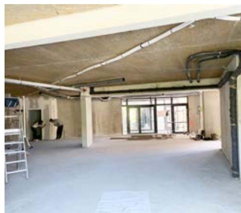
Malgré ce démarrage perturbé, les entreprises missionnées sont aujourd'hui pleinement à l'ouvrage et prévoient d'ici la fin du mois de juillet la réalisation de l'ensemble des travaux de plomberie, électricité, installation des cloisons, revêtement de sol, peintures et climatisation.
